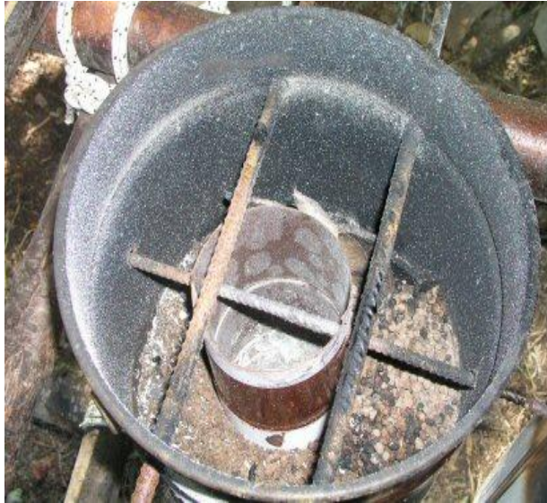
Foto dall'alto, dove si nota il sistema di fissaggio e la presenza dell'isolante (argilla espansa)
